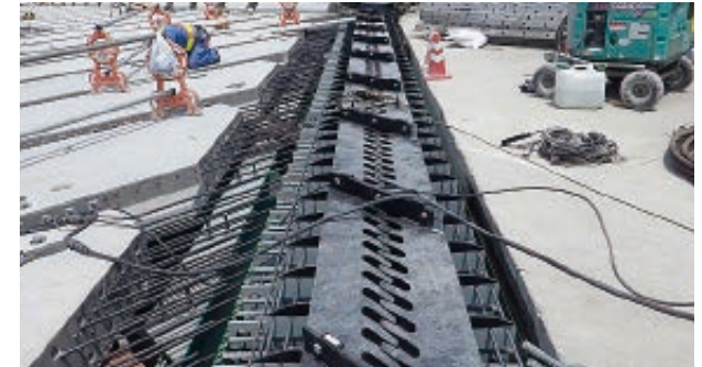
Laying the PCa deck
