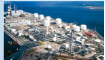
Tokyo Gas—Negishi LNG Plant
