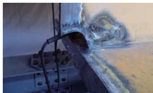
Fig. 17 Grooved weld edge
