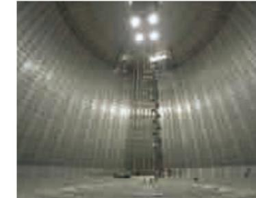
世界最大容量LNG地下タンク(メンブレン)
