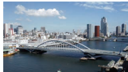
拱桥“筑地大桥”
