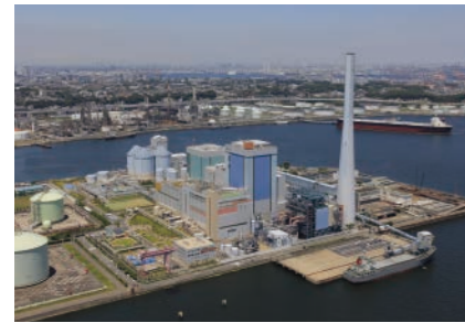
专业大型锅炉（塔型锅炉） 图片提供：J-POWER [电源开发（株）]
