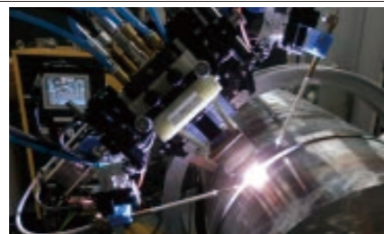
用于大型锅炉管道的自动焊接设备
