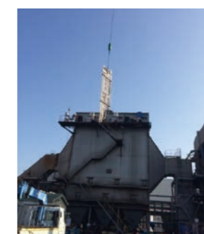
A-USC型锅炉实用试验的安装情况
