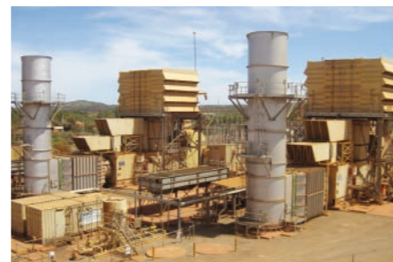
② 燃气轮机发电成套设备 (LM6000 简单循环)
