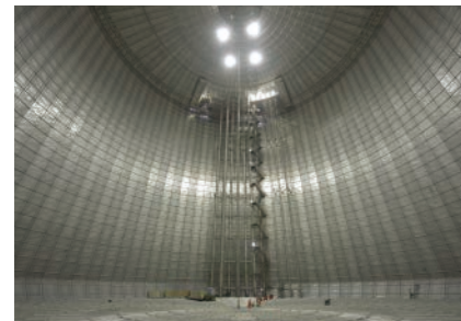
世界最大容量LNG 地下储气罐（膜结构） 照片提供：东京瓦斯株式会社
