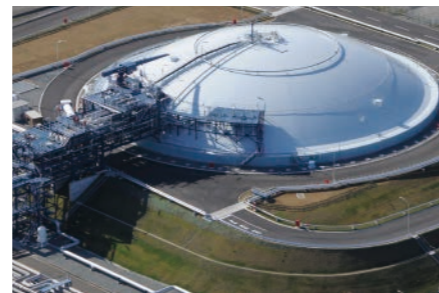
① LNG 地下储罐
