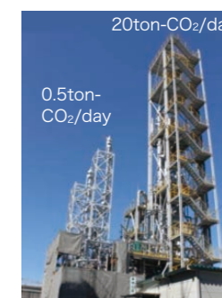
用于CO 2 分离与回收的20ton-CO 2 /day试验工厂以及运往澳大利亚前的0.5ton-CO 2 /day实验机 (于IHI相生工厂)
