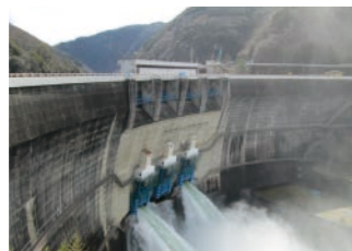
水库用水闸设备
