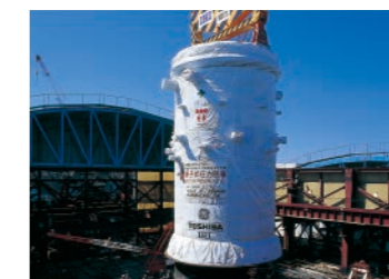
原子反应堆压力容器
