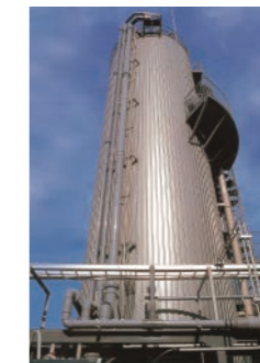
污水处理设施
