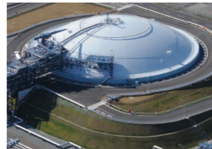
LNG 地下储罐
