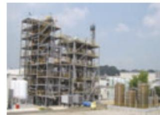
二塔式ガス化炉
