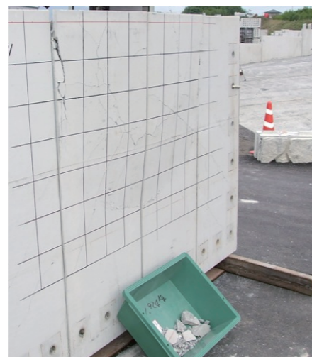
DEW パネルを用いた壁高欄
