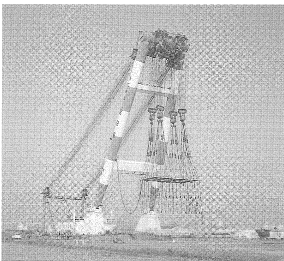
第 15 図 起重機船全景 (制振装置設置状態)
