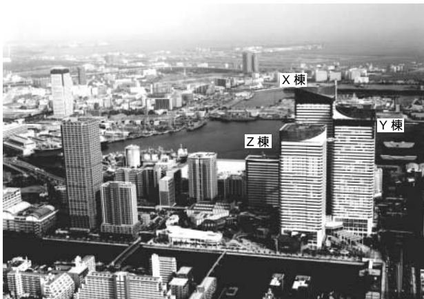
第1図 オフィスX棟・Y棟・Z棟の概観
