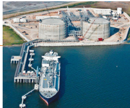
Gulf LNG Energy LLC社向け LNG受入ターミナル完成写真
