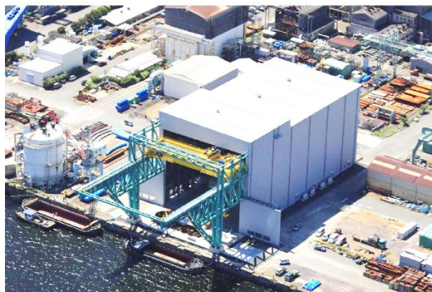
PWR向け蒸気発生器の製造新工場(横浜事業所内)
