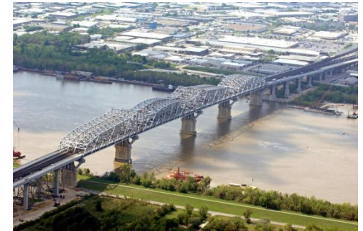
米国 ヒューイ・P・ロング橋 (2012年7月拡幅工事完成)
