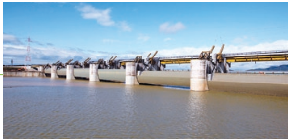
大河津新可動堰完成写真
