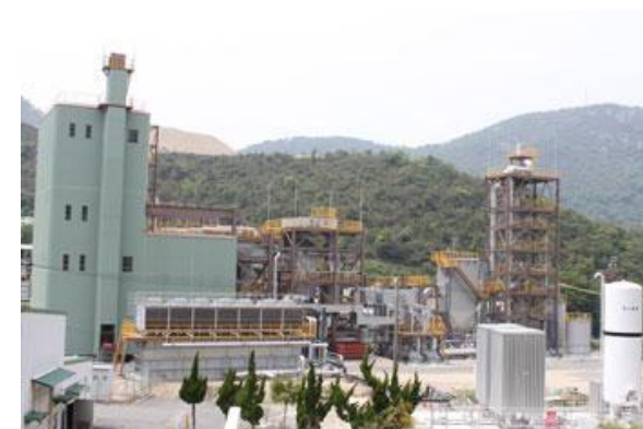
相生事業所内 石炭燃焼試験設備
