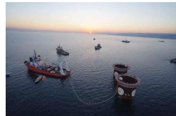
主塔基礎ケーソンの海中への沈設
