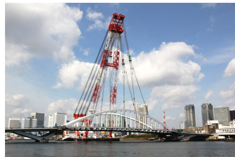
「築地大橋」の架設
