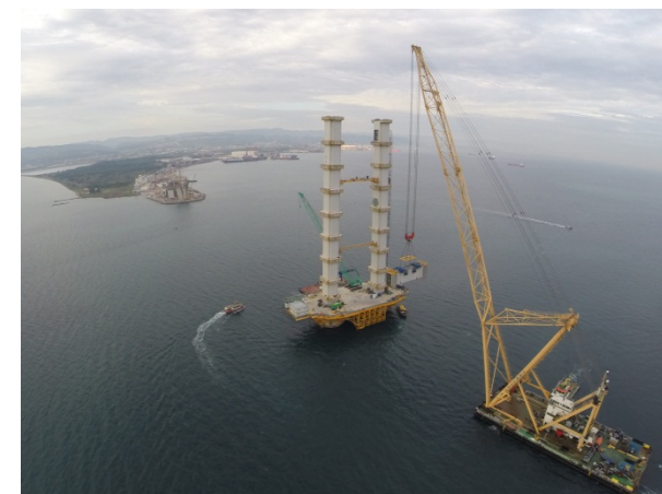
南側主塔の下水平梁の架設作業
