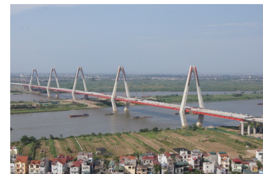
ニャットン橋
