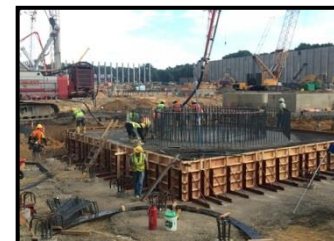
主熱交換器基礎工事
