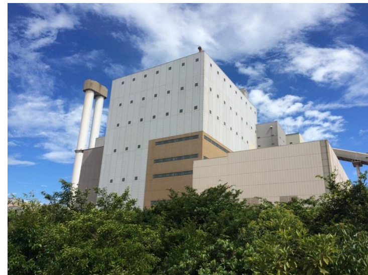
IHIが納入した、神戸製鋼所殿向け神鋼神戸発電所2号機
