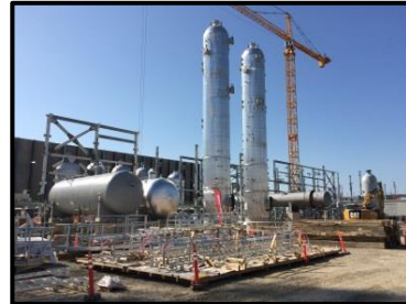
酸性ガス吸収塔据付
