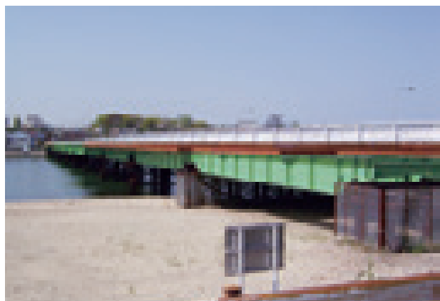
芦屋橋仮橋(福岡県) 構造形式:鋼鈹桁 橋長:252.0m 竣工年:2011年
