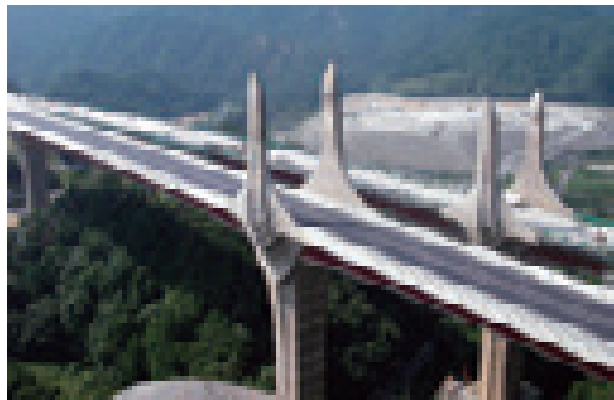
近江大島橋(滋賀県) 構造形式:PC5径間連続エクストラードズ波型鋼板ウェブ橋 橋長:555.0m 竣工年:2007年
