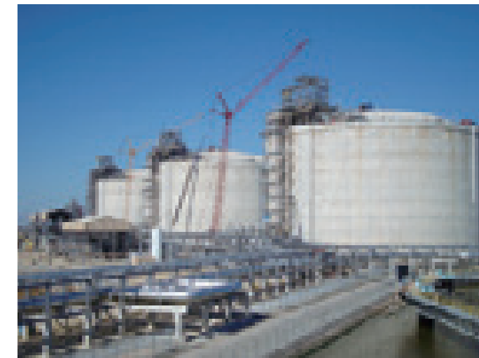
キャメロンLNGタンク(アメリカ) 構造形式:地上式PC LNGタンク 容量:16万m 3 /基 竣工年:2009年
