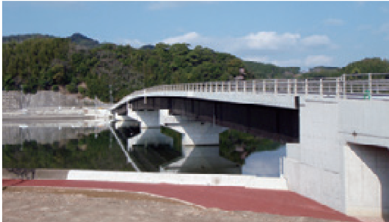
瀬戸中央橋 (長崎県) 構造形式: 鋼4径間連続非合成箱桁橋 橋長: 228.0m 鋼重: 901t 竣工年: 2009年
