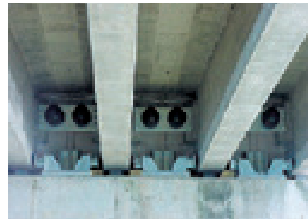
コンクリート橋
