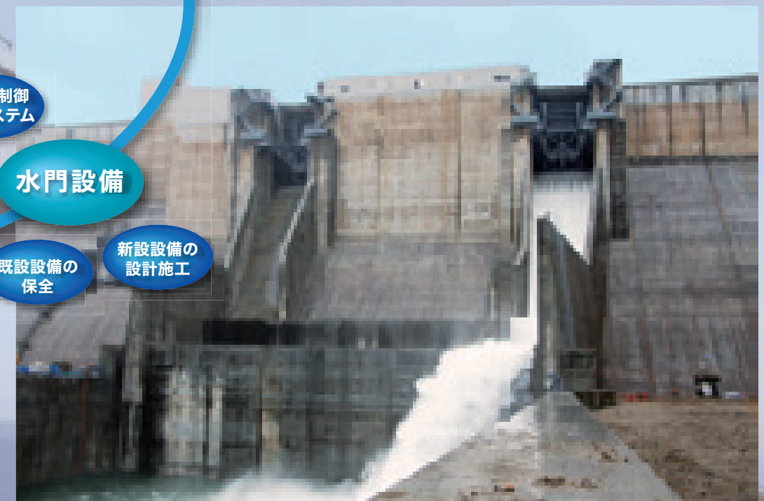
尾原ダム(非常用放流設備(クレストゲート))
