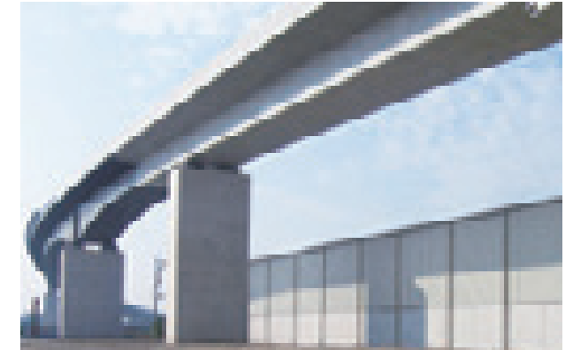
大牟田高架橋(福岡県) 構造形式:5径間連続鋼・コンクリート混合箱桁橋 施工長:354.0m 竣工年:2007年
