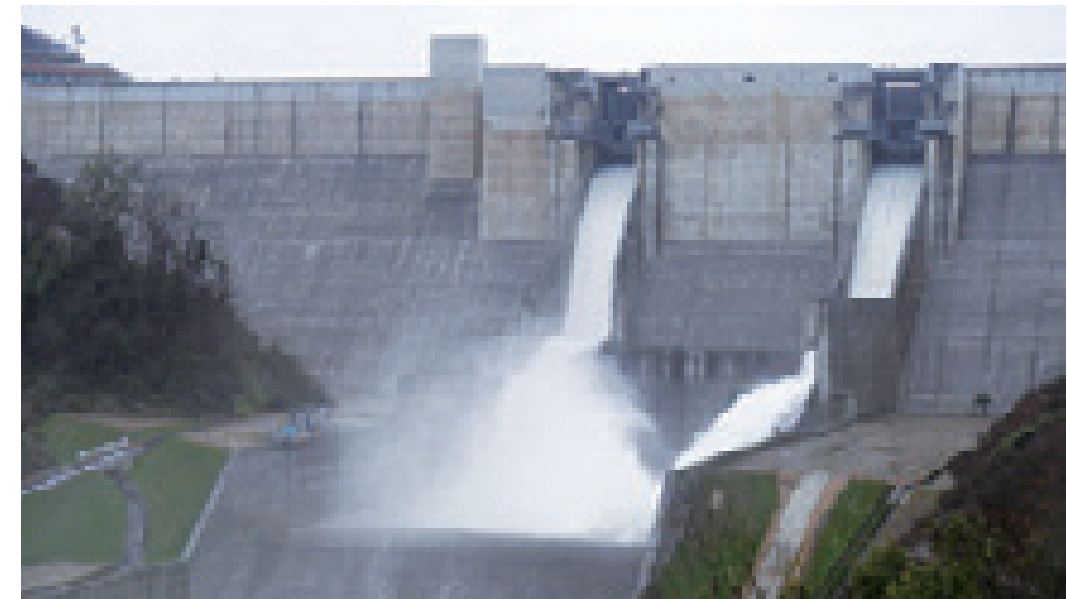
尾原ダム(島根県) 設備名:非常用放流設備(クレストゲート) 形式:鋼製ラジアルゲート 数量:2門 純径間:11.500m 有効高:14.020m 開閉装置形式:油圧シリンダー式 竣工年:2011年
