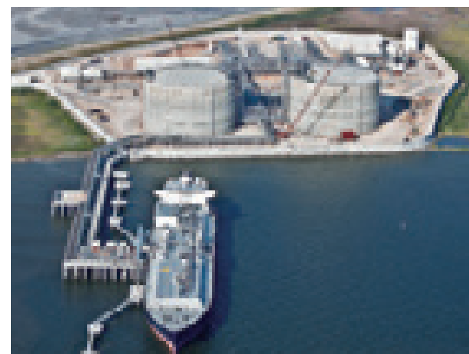
ガルフLNGクリーンエネルギーPJ(アメリカ) 構造形式:地上式PC LNGタンク 容量:16万m 3 /基 竣工年:2012年
