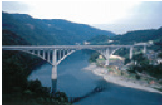
池田へそっ湖大橋(徳島県)【田中賞受賞】 構造形式:PC5径間連続バランスドアーチ橋 橋長:705.0m 竣工年:1999年
