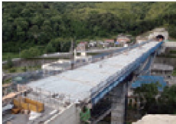
上戸町高架橋 (長崎県) 構造形式: 鋼3径間連続非合成板桁橋 橋長: 148.0m 鋼重: 344t 竣工年: 2011年
