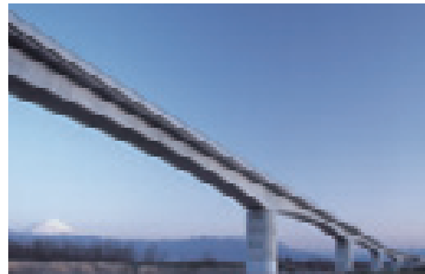
釜無川橋(山梨県) 構造形式:PC8径間連続ラーメン箱桁橋 橋長:753.0m 竣工年:2001年
