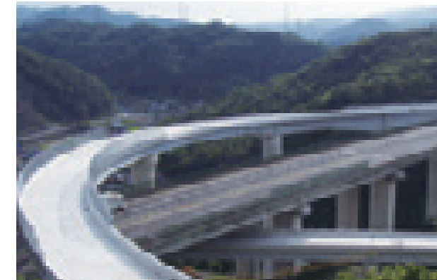
尾道ジャンクションランプ橋(広島県) 構造形式:鋼3径間連続非合成箱桁橋+PC3径間連続ラーメン箱桁橋 橋長:376.0m 竣工年:2007年
