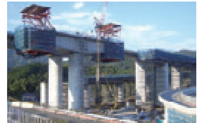
入野高架橋(静岡県) 構造形式:PC10径間連続波形鋼板ウェブ箱桁橋 橋長:679.0m 竣工年:2010年
