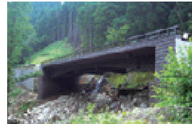
こころ橋(奈良県) 構造形式:PRCエクストラードズポータルラーメン橋 橋長:52.0m 竣工年:2004年
