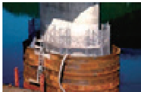
④排水後、仮締切完了
