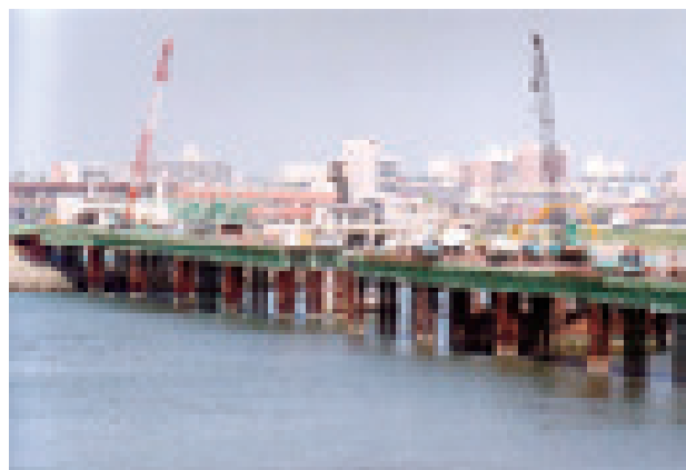
新小戸之橋仮橋(宮崎県) 構造形式:鋼上路式トラス・下路式トラス 橋長:552.0m 竣工年:2005年
