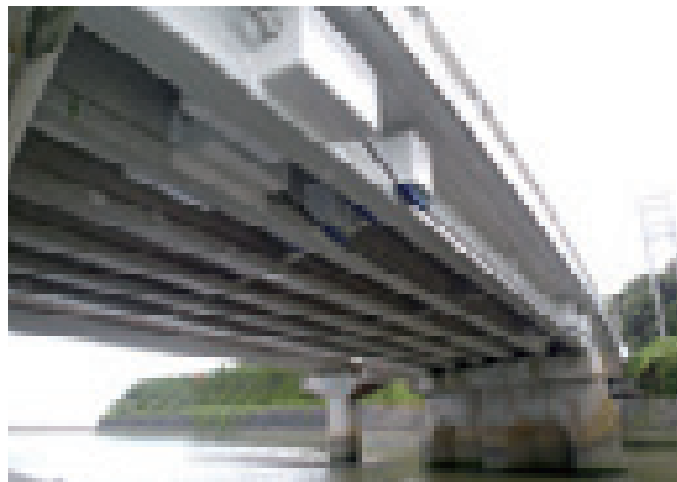
PC桁補強
