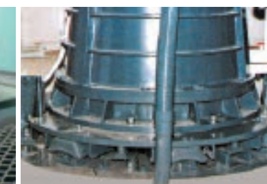
縦型ポンプ防振装置
