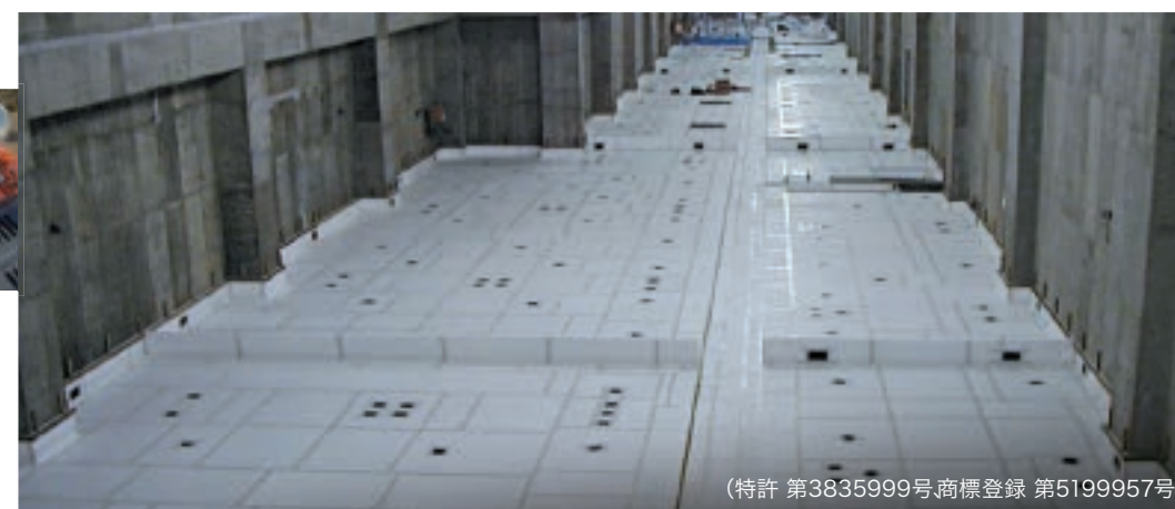
INC防振マット(集合住宅固体音対策)
