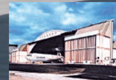
大型航空機用ハンガ型消音装置
