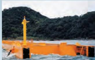
沖合に浮かせて消波、防波を行います。海洋構造物技術に支えられたデザインが安定した性能を生み出しています。大水深・軟弱地盤の海域に対して、経済性・施工性で有効な防波堤であり、海水交流を阻害しない環境にやさしい構造物です。
