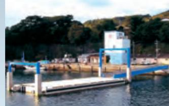
潮汐に関わらず、水面からの天端高さが一定で、船と岸壁の間の段差を解消できます。また、杭保留なので浮体の動揺が小さく、荷積み陸揚げ作業もスムーズにできます。
