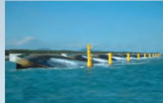
海岸浸食防止と海岸域の多目的利用を目的として、(独)土木研究所と共同開発された大水深型有脚式離岸堤です。
