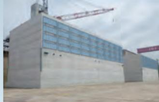
港湾・漁港の施設として、防波堤・岸壁・護岸などに使われます。鋼板とコンクリートのハイブリッド(合成)構造を採用し、高強度で、複雑な形状に対応できることが特長です。
