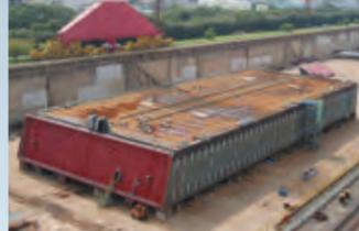
海底トンネルを築造するための1エレメント(函体)であり、その大きさは曳航・沈設作業において支障のない大きさに分割されています。構造形式は、鋼コンクリート合成構造、鉄筋コンクリート構造等があります。
