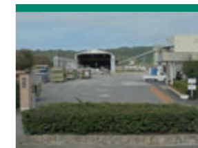
16 昭和コンクリート工業株式会社 滋賀工場 工場/ 滋賀県甲賀市土山町市場361-4
