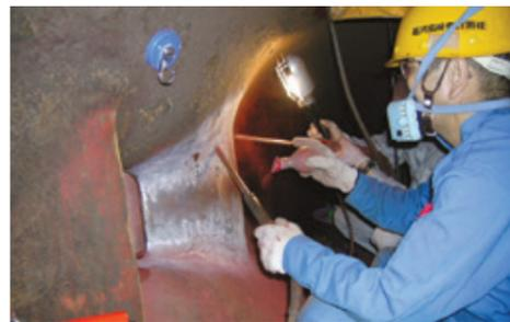
水車内部(ケーシング)の非破壊検査
