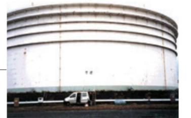
AEによるタンク底板腐食監視
