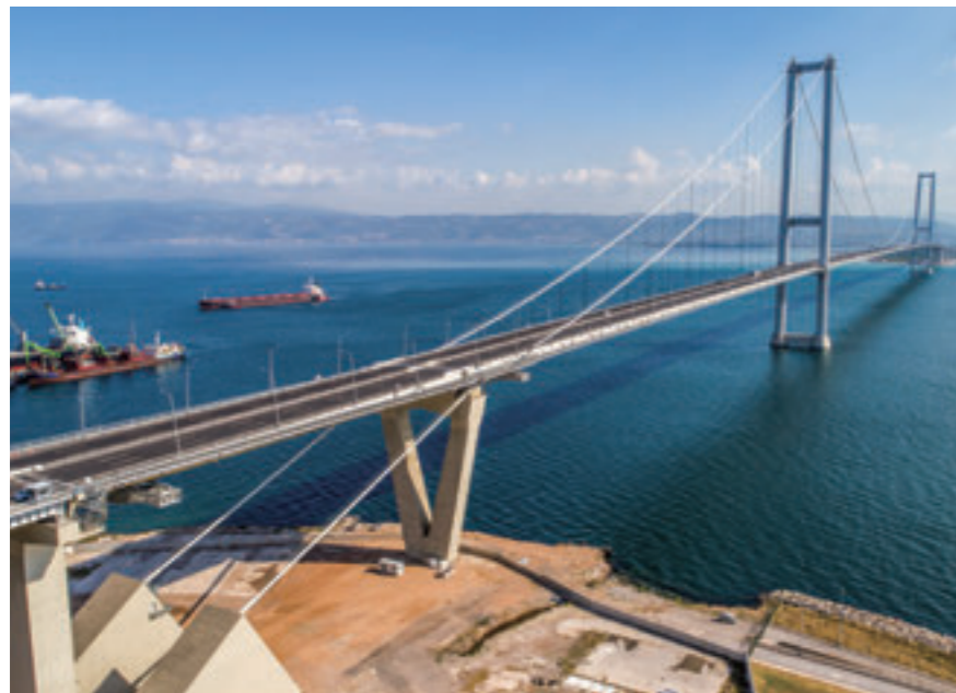
吊橋(オスマン・ガーズィー橋)
