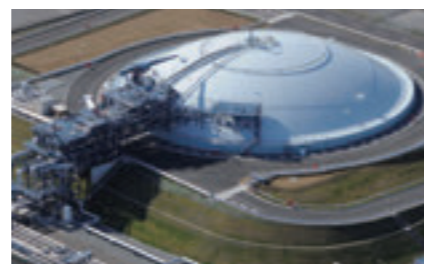
LNG地下タンク
