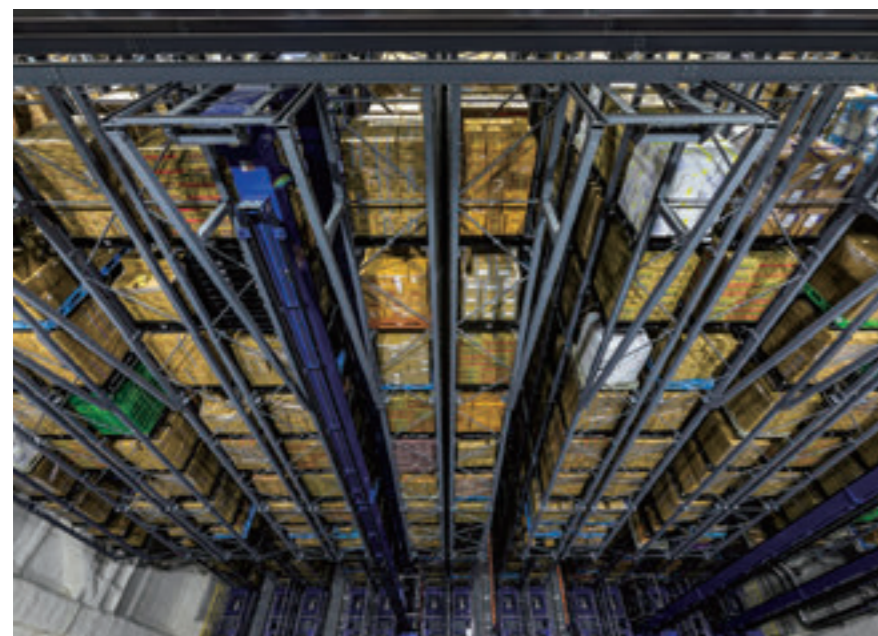
冷凍自動倉庫
