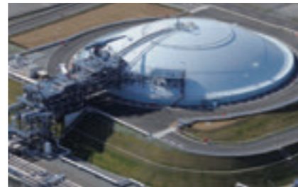
In-ground LNG storage tank
