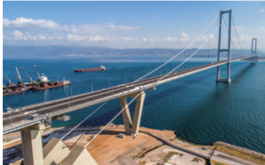
吊橋(オスマン・ガーズィー橋)
