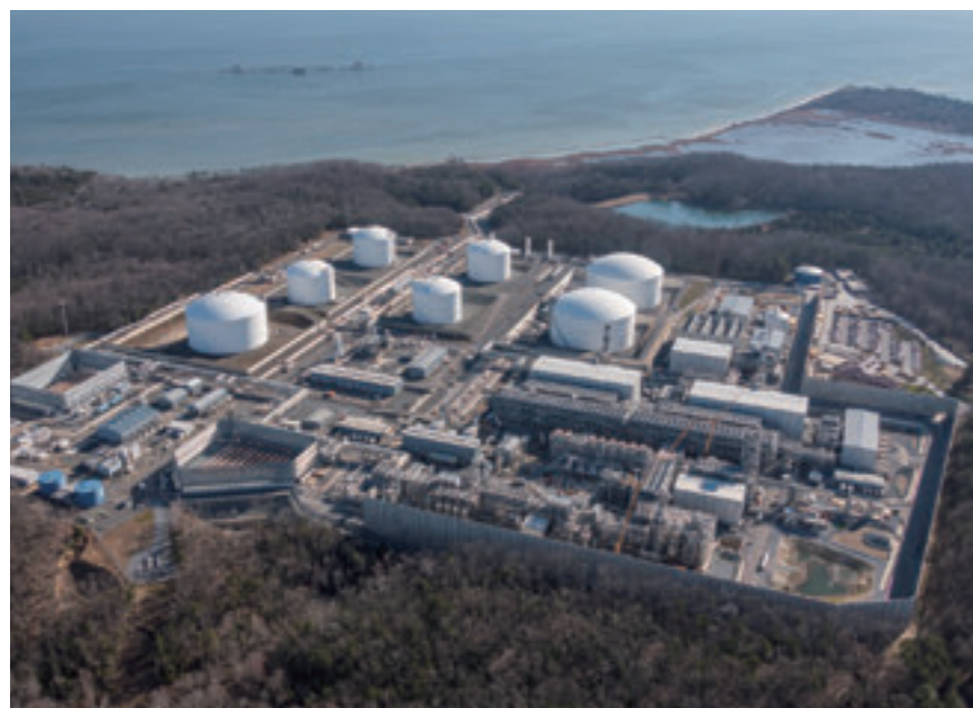
天然ガス液化プラント
