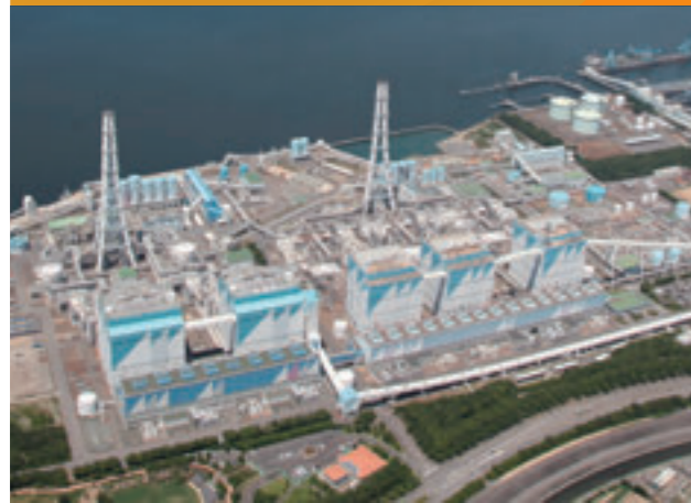
アンモニア燃焼技術 写真提供:株式会社JERA(碧南火力発電所)
