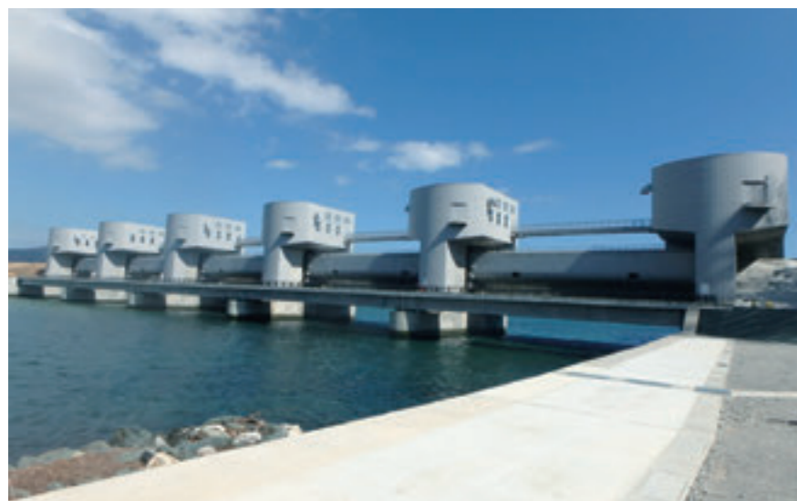
河川用ゲート(気仙川水門)
