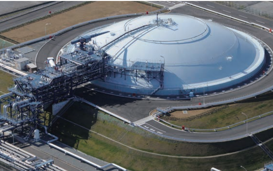
LNG 地下储罐
