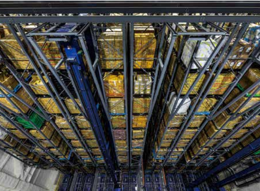
冷凍自動倉庫
