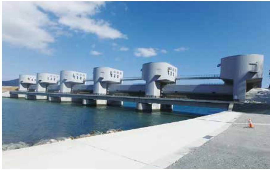
河川用ゲート(気仙川水門)
