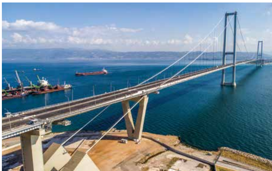
吊橋(オスマン・ガーズィー橋)
