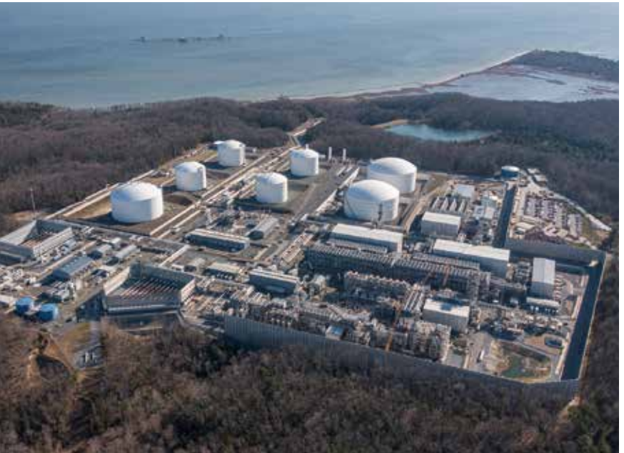
天然ガス液化プラント
