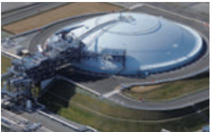
LNG地下タンク
