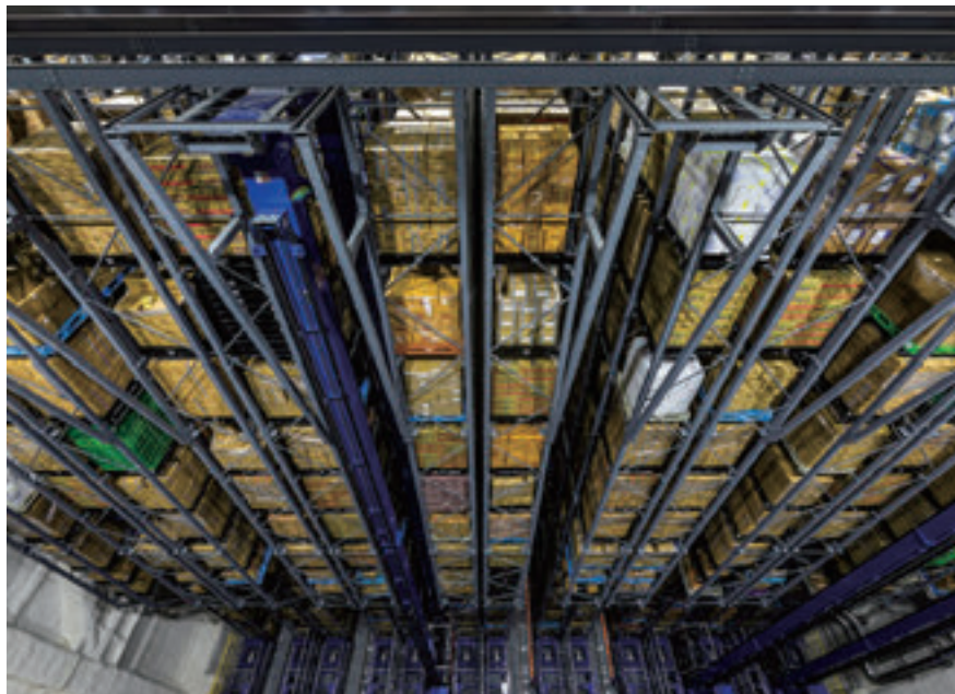
冷凍自動倉庫
