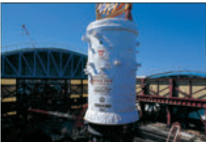
原子炉圧力容器
