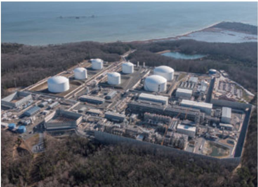
天然ガス液化プラント
