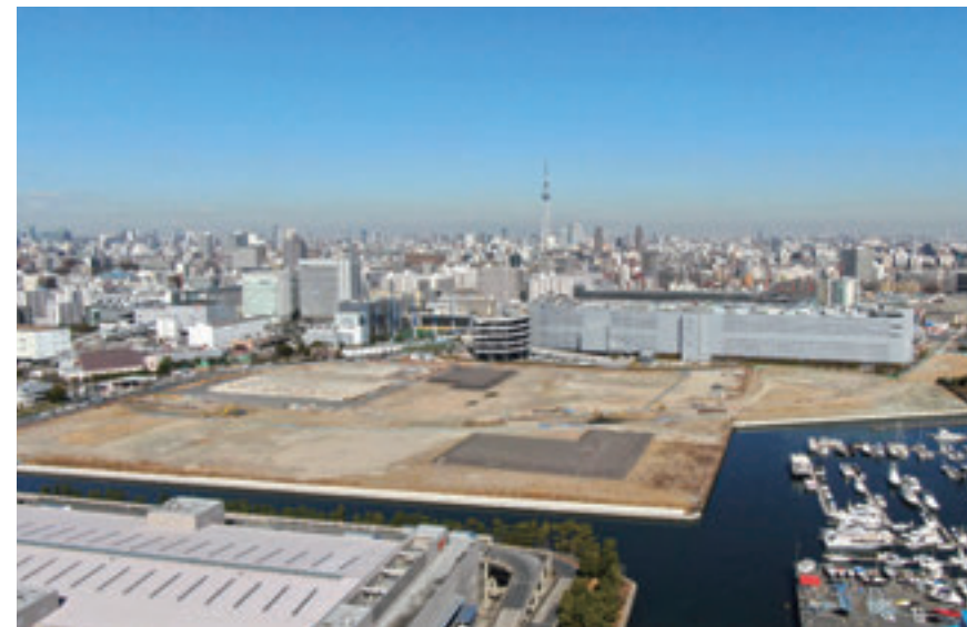
再開発に向けてインフラ整備を進める旧砂町工場跡地(東京都江東区新砂)
