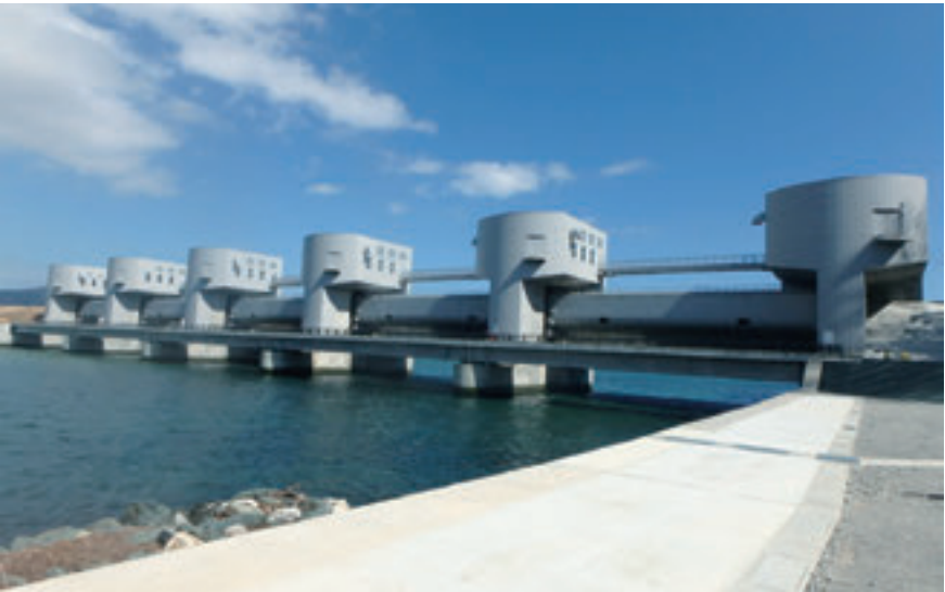
河川用ゲート（気仙川水門）
