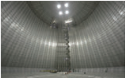
世界最大容量LNG地下タンク(メンブレン) 写真提供:東京ガス(株)
