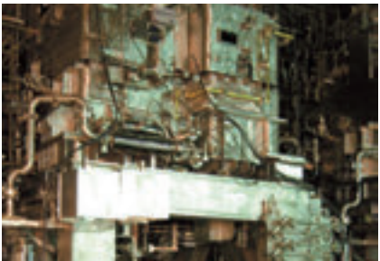
高レベル廃液ガラス固化設備
