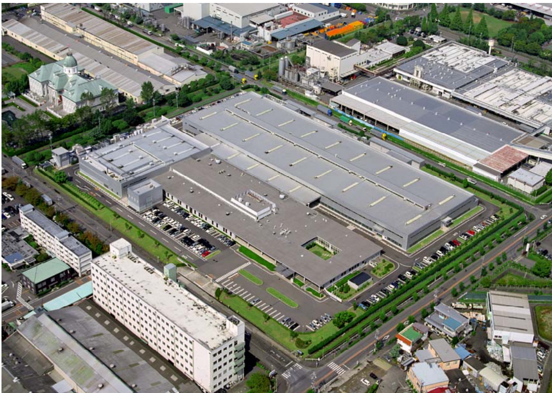
Tokyu Co., Ltd., Inuyama plant, Japan
