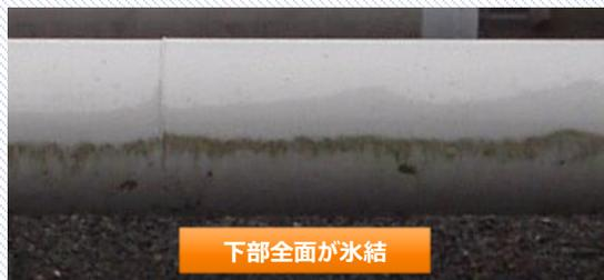
配管保冷材を劣化調査し、基地の計画的な保冷更新工事を提案
