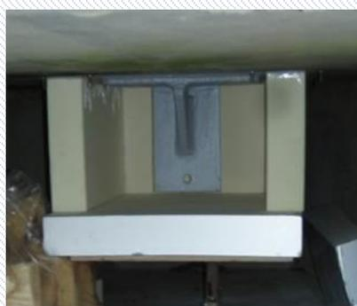
塗装、保冷材カバーにより環境要因を排除することで、SCC発生を抑制。
