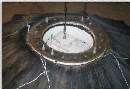
炭素鋼製ウェイトボックスの場合、錆が貫通し、タンク内外槽間に大気が混入するケースがあります。IHIではダイアフラムの更新時に、ウェイトボックスのステンレス化を推奨しています。
