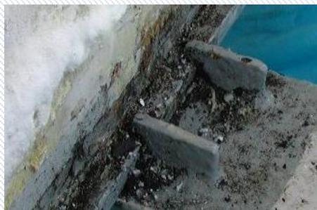
配管サポートの腐食等の損傷を点検し、耐震性能等に問題ある場合は取替工事を実施
