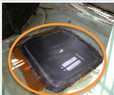
腐食により貫通したタンク外槽屋根を当て板補修
