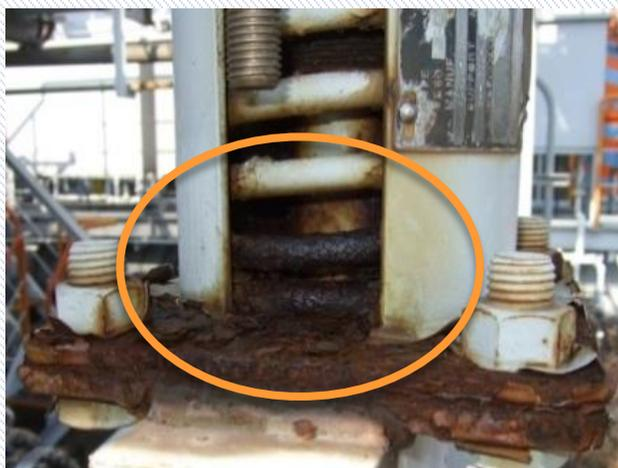
ばね錆により配管のサポート機能を喪失
