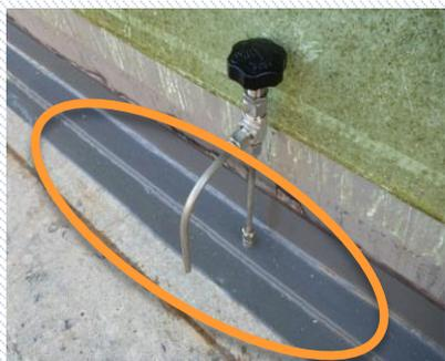
外槽底部の貫通欠陥を強固なシール材にて漏洩防止
