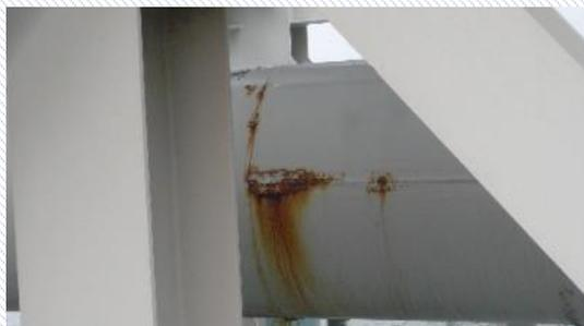
配管塗膜の劣化調査を実施し、計画的な塗装更新工事を提案、設備の健全性保持のため必要に応じて再塗装を実施
