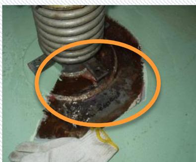
腐食により貫通したノズル周辺部を当て板補修
