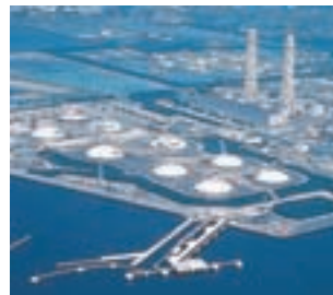
LNG receiving terminals
