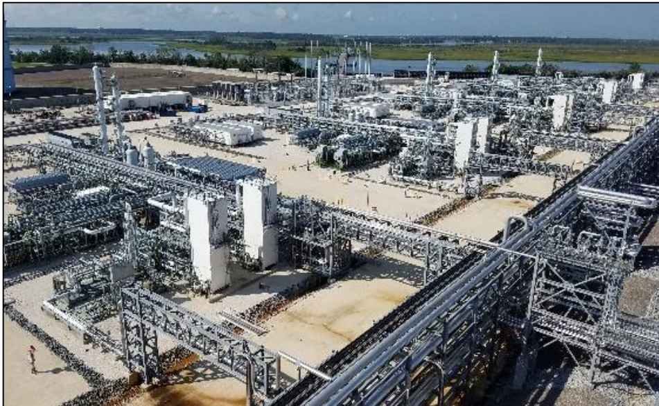
Actual Construction Completion
