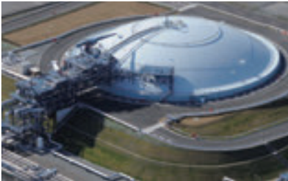
In-ground LNG storage tank
