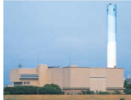
生物质处理设施 (东京23区垃圾处理联合体)
