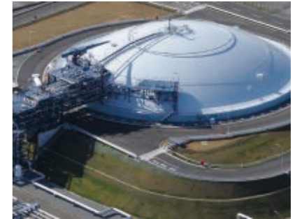
LNG 地下储罐
