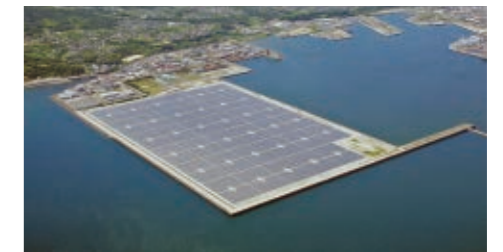
鹿儿岛兆瓦级太阳能发电站
