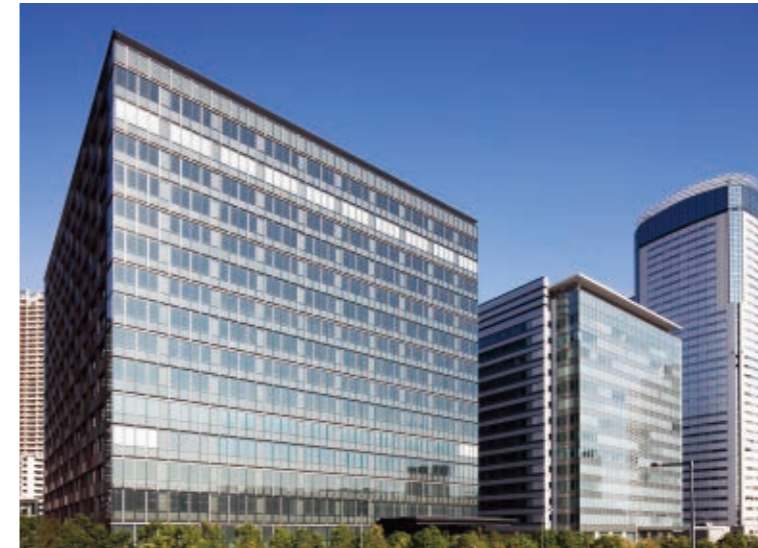
租赁办公大楼“丰洲FORESIA™”和“丰洲FRONT™”
