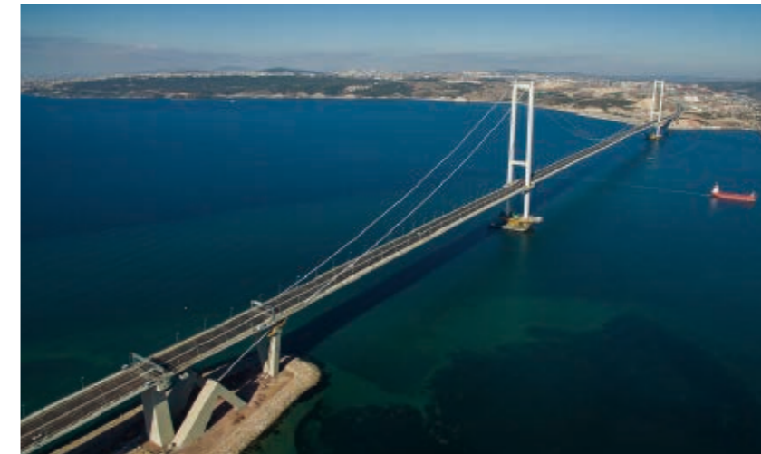
吊桥“Osman Gazi大桥”（Izmit湾跨海大桥）
