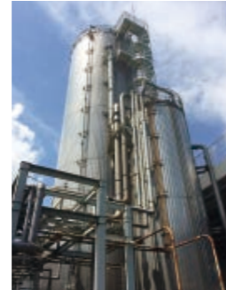
污水处理设施
