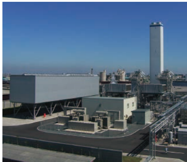
燃气轮机复合发电设备“LM6000”
