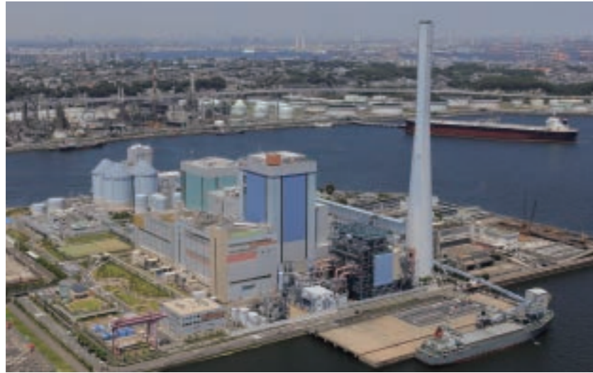
专业大型锅炉（塔型锅炉） 图片提供：J-POWER【电源开发（株）】
