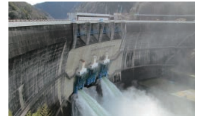
水库用水闸设备
