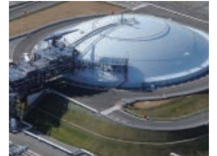
LNG 地下储罐
