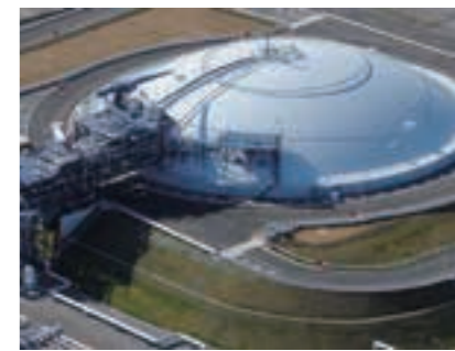
LNG地下储罐
