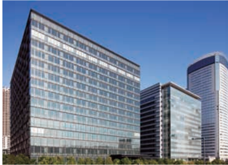
租赁办公大楼“丰洲FORESIA™”和“丰洲FRONT™”
