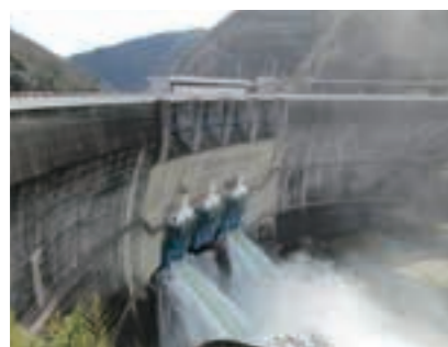
水库用水闸设备
