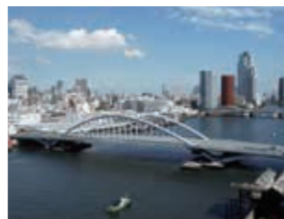
拱桥“筑地大桥”
