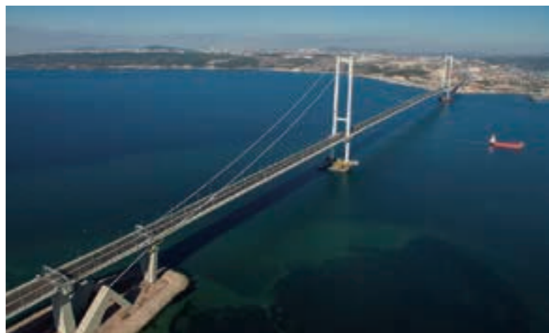
吊桥“Osman Gazi大桥”（Izmit湾跨海大桥）
