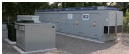
大型能源储存系统
