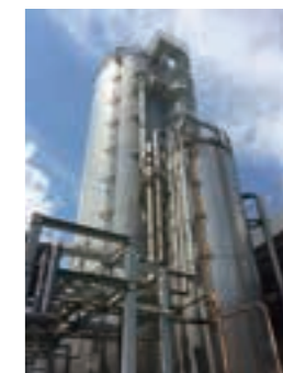
废水处理设施
