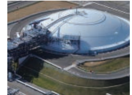
In-ground LNG storage tank
