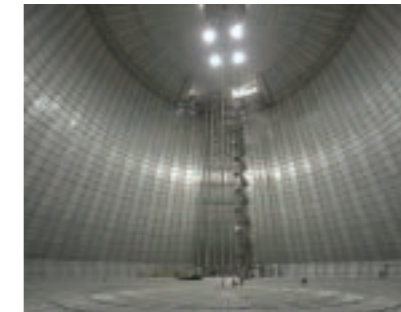
世界最大容量LNG地下タンク(メンブレン) 写真提供:東京ガス(株)
