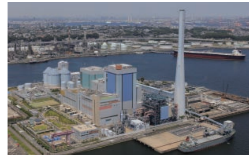
事業用大型ボイラ(タワー型ボイラ) 写真提供: J-POWER[電源開発株]
