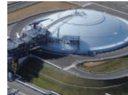
LNG地下タンク
