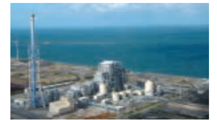
IPP・PPS設備用ボイラ
