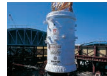
原子炉圧力容器
