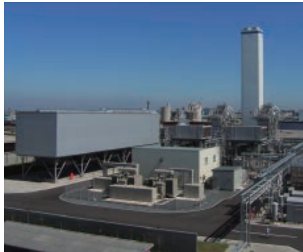
LM6000ガスタービン複合発電設備
