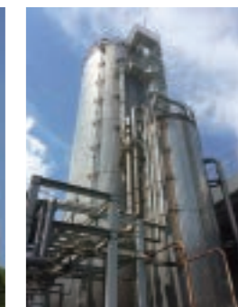
排水処理設備
