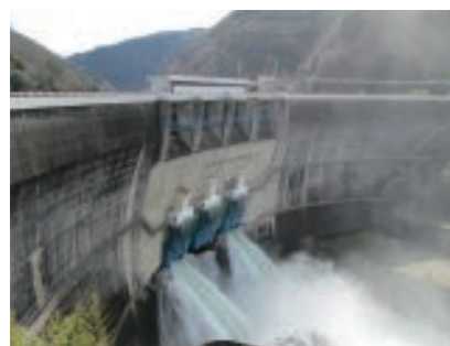
ダム用ゲート
