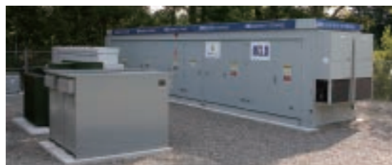
大型エネルギー貯蔵システム
