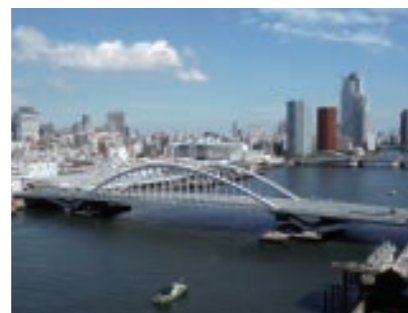
アーチ橋“築地大橋”
