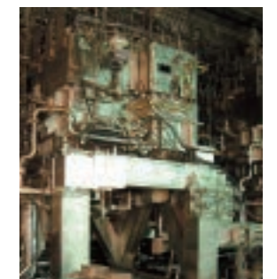
高レベル廃液ガラス固化設備
