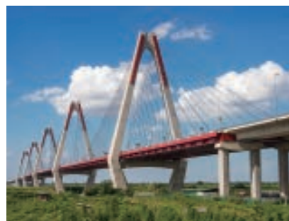
斜張橋“ニャタン橋”
