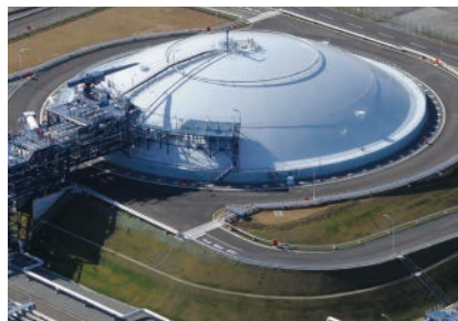
In-ground LNG storage tank
