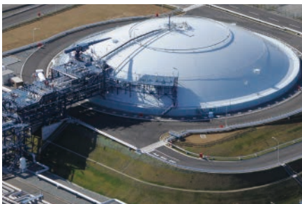
▲ In-ground LNG storage tank
