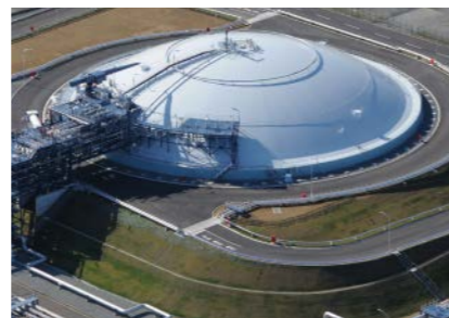
LNG地下タンク
