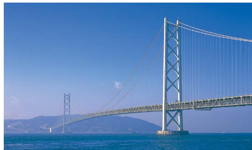
吊橋“明石海峡大橋”
