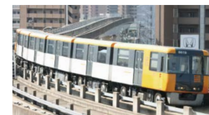
広島高速交通 アストラムライン
