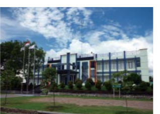
24 PT. Cilegon Fabricators (インドネシア) 敷地面積 250,000㎡ 主要製品 ボイラ、鉄骨、コンテナクレーン、各種配管、圧力容器、HRSG 資格 ISO 9001、ASME (S, U, PP)、OHSAS 18001
