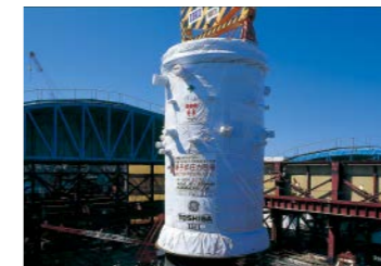
原子炉圧力容器
