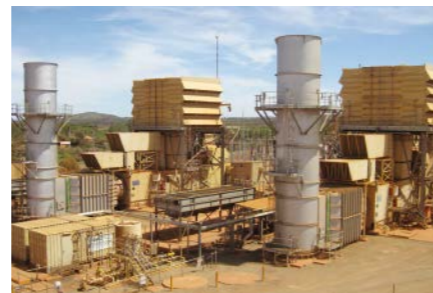
● ガスタービン発電プラント (LM6000シンプルサイクル)
