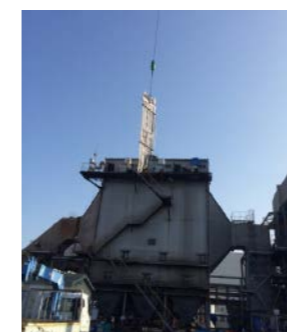
A-USCボイラ実証試験の据付状況
