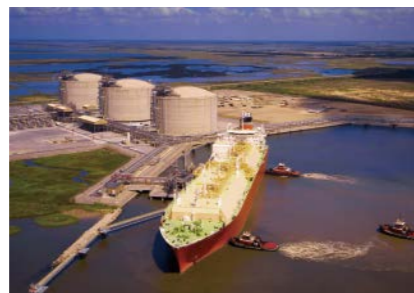
LNG受入基地 (Sempra向けCameron LNG受入基地(米国ルイジアナ州))
