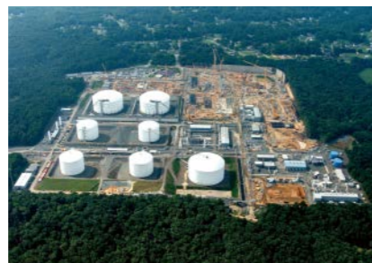
天然ガス液化プラント
