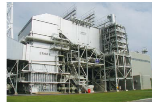
排煙処理設備
