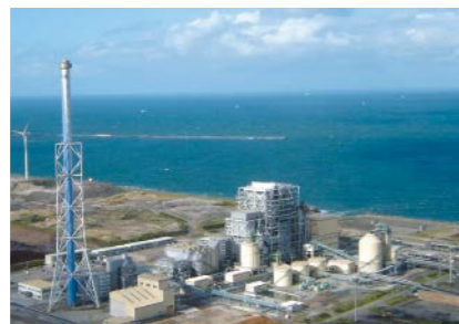
IPP・PPS設備用ボイラ
