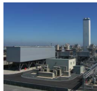
ガスタービン複合発電設備"LM6000"
