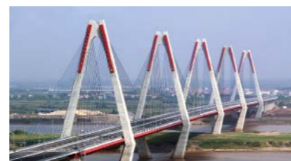
斜張橋“ニヤッタン橋”
