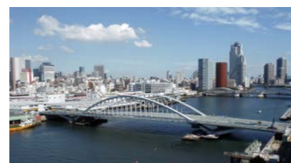
アーチ橋“築地大橋”
