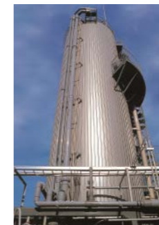
排水処理設備
