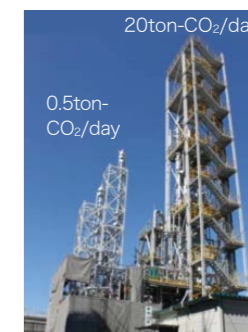
CO 2 分離・回収の20ton-CO 2 /dayパイロットプラントおよびオーストラリアへ出荷前の0.5ton-CO 2 /day実証機（IHI相生工場）
