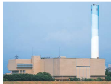
バイオマス処理施設 (東京二十三区一部事務組合 提供・協力)
