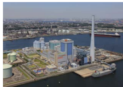
事業用大型ボイラ(タワー型ボイラ) 写真提供: J-POWER[電源開発株]
