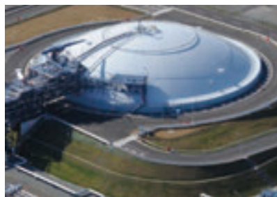
In-ground LNG storage tank
