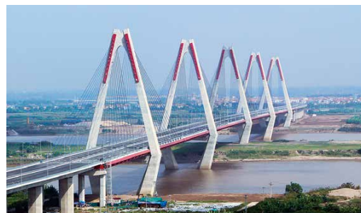
ニャットン橋
