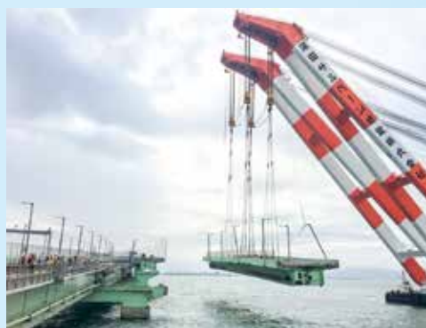
損傷した橋桁の撤去状況
