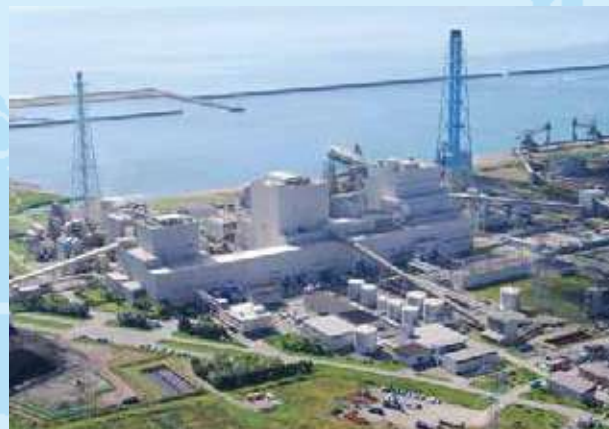
北海道電力苫東厚真発電所
