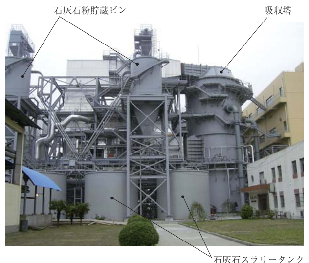
第 1 図 外高橋脱硫装置の全景
