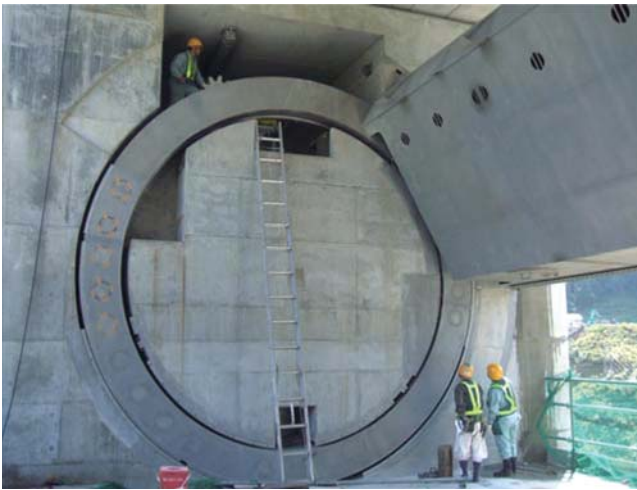
第5図 試運転調整の状況
