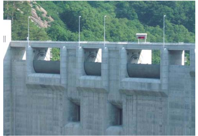
第6図 完成全景
