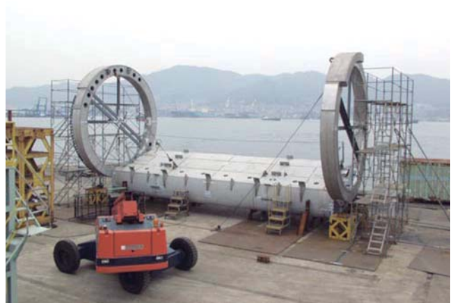
第3図 扉体の工場仮組立状況
