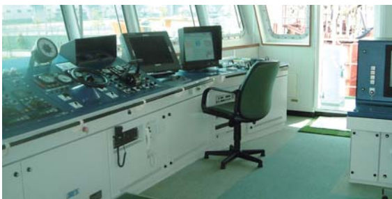
第2図 操舵室内コンソール
