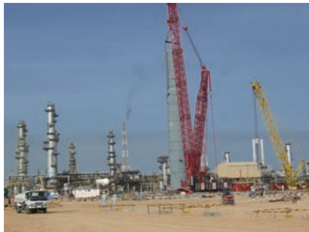
タワー据付け
