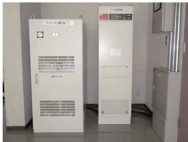
リチウムイオン電池 (左) とグリッド管理装置 (右)
