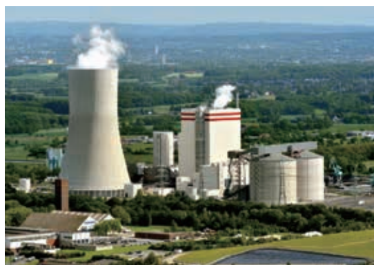
第 1 図 トリアネル社ドイツ・リューネン発電所全景 Fig. 1 Trianel Lünen Power Plant
